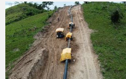
Abertura de Faixa e instalação dos tubos
