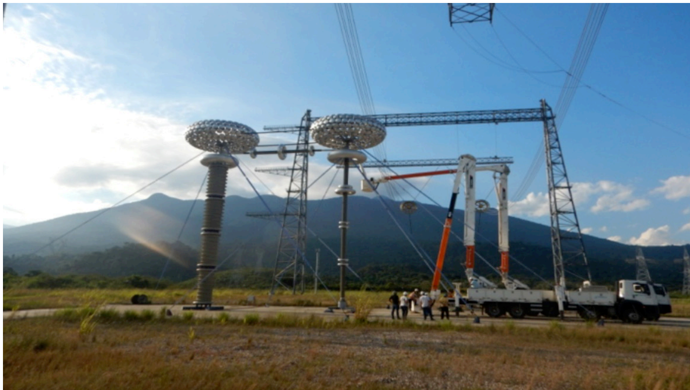
Figura 3 - Ensaio dielétrico no Lab-UAT Externo
